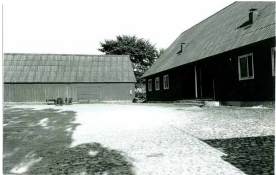
Befälsbaracken som ersatte Dammåkragården som revs 2019.
