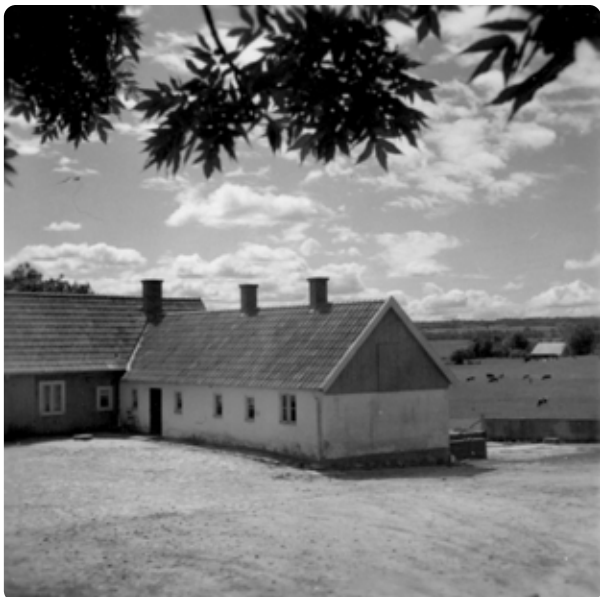
Baksidan av Dammåkragården där skjutfältsfanjunkaren hade sitt kontor.
