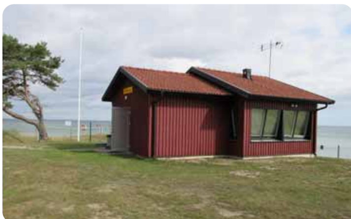
Sjökontrollen. Härifrån sker övervakning av säkerhets- området till havs. Gamla tor- net är rivet och en ny radarmast byggd.
