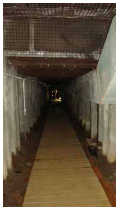
Helsingborgs skyddsrum under Kärnan med plats för ca 500 sittande.
